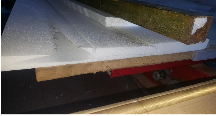
Şekil 6. Straforun CNC'ye yerleştirilmesi
