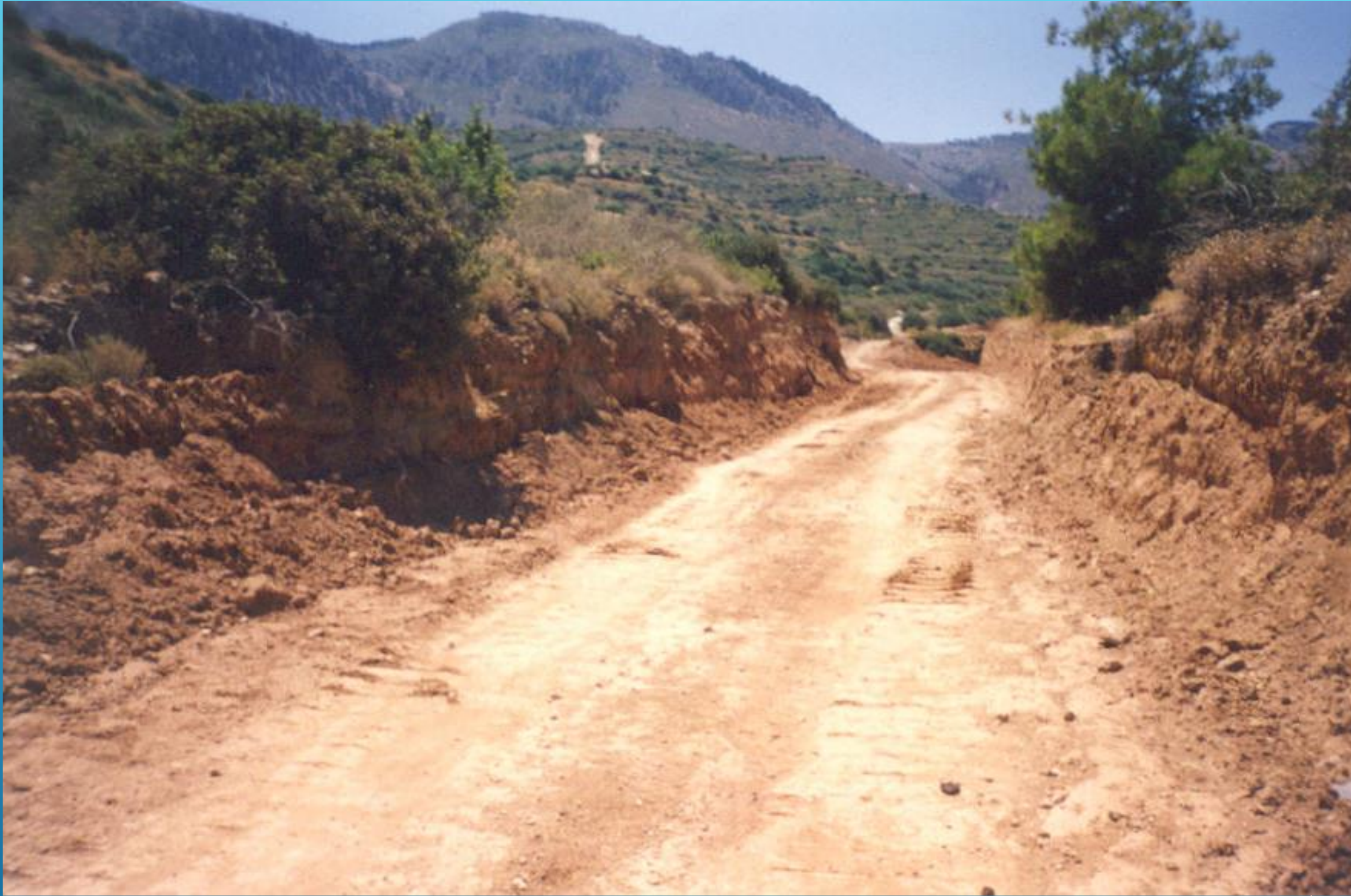
İki Kazı Şevi Arasında İnşa Edilmiş Bir Orman Yolu
