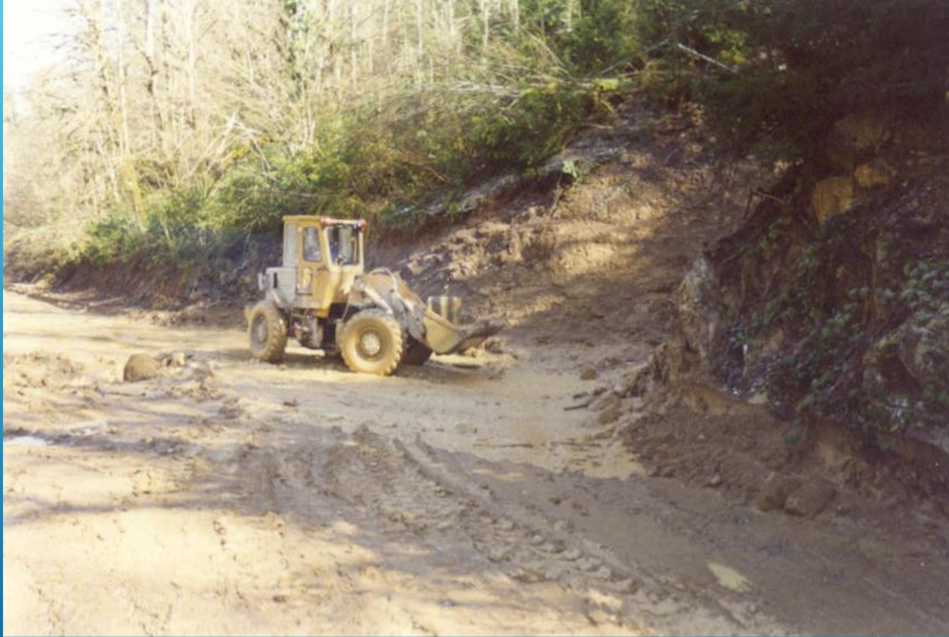
Lastik Tekerlekli Bir Ykleyici ile Yol Őevinde Bakım alıŐması
