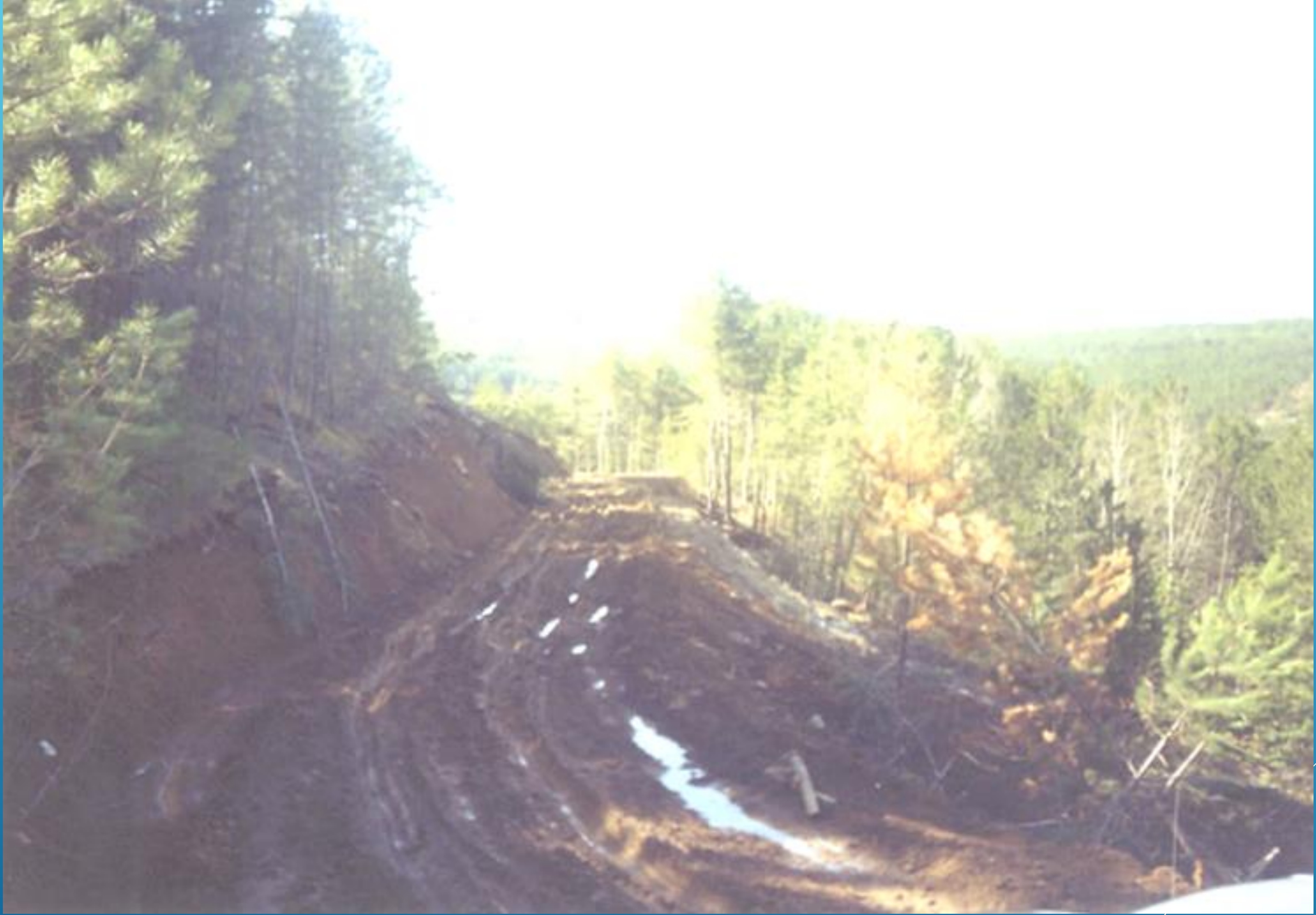
Zemini İyİ Drene Edilmemiş ve Gölgeİİ Bakıdan Geçirilmiş Orman Yolu
