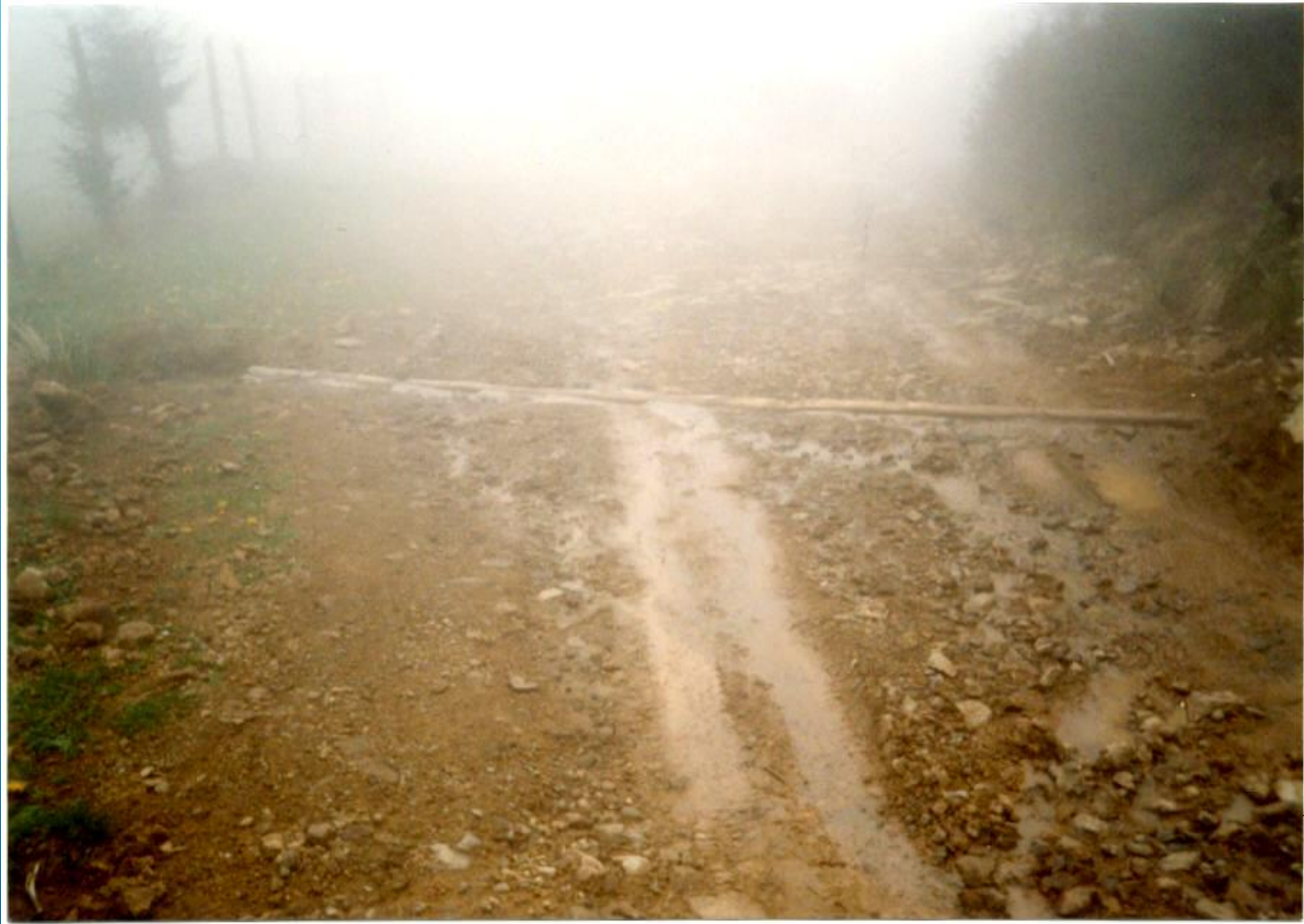
Orman Yoluna Verev Yerleştirilmiş Su Akıtıcı Ahşap Kasis
