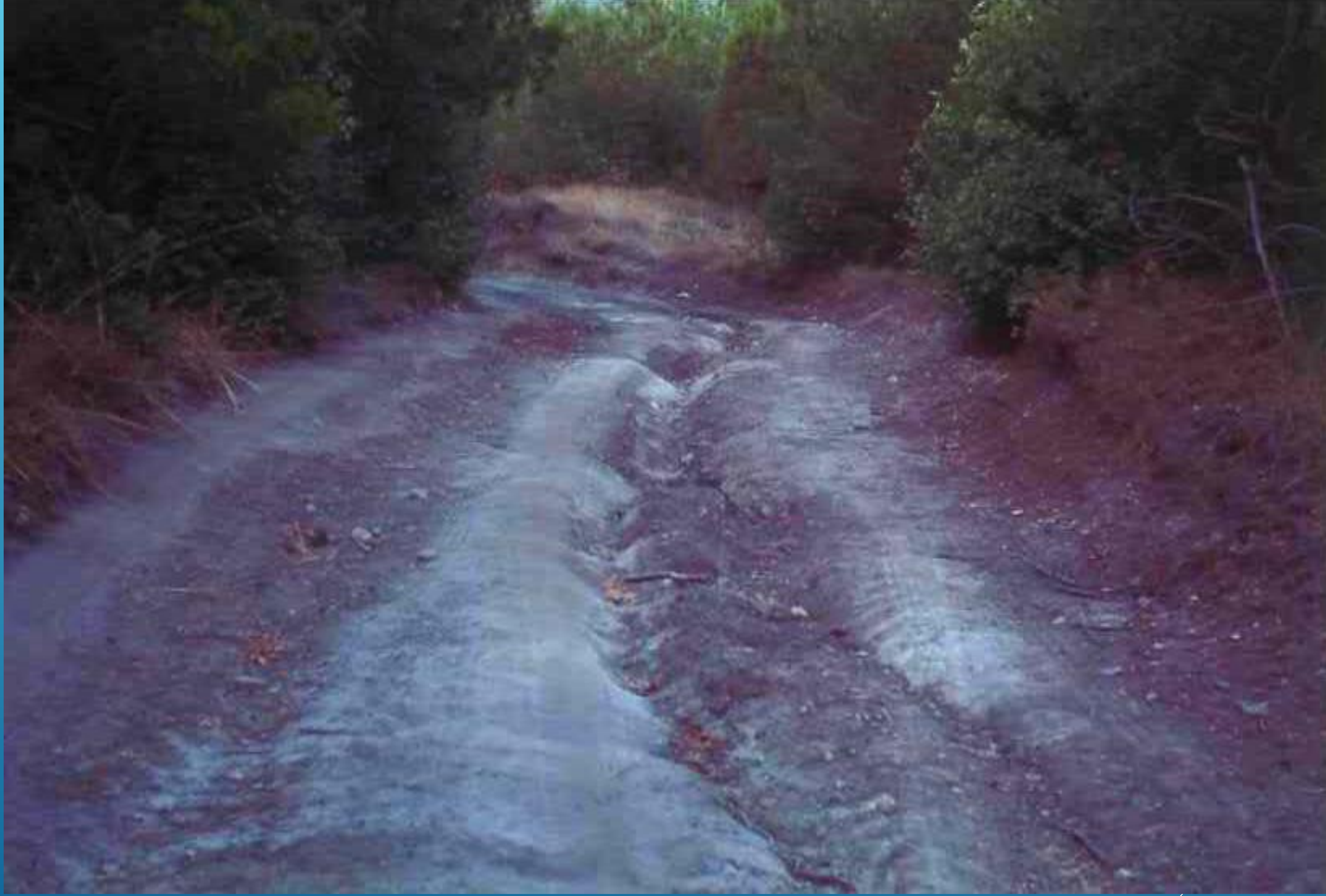
Yağıř Sonrası Yol Üst Yapısının Bozulması
