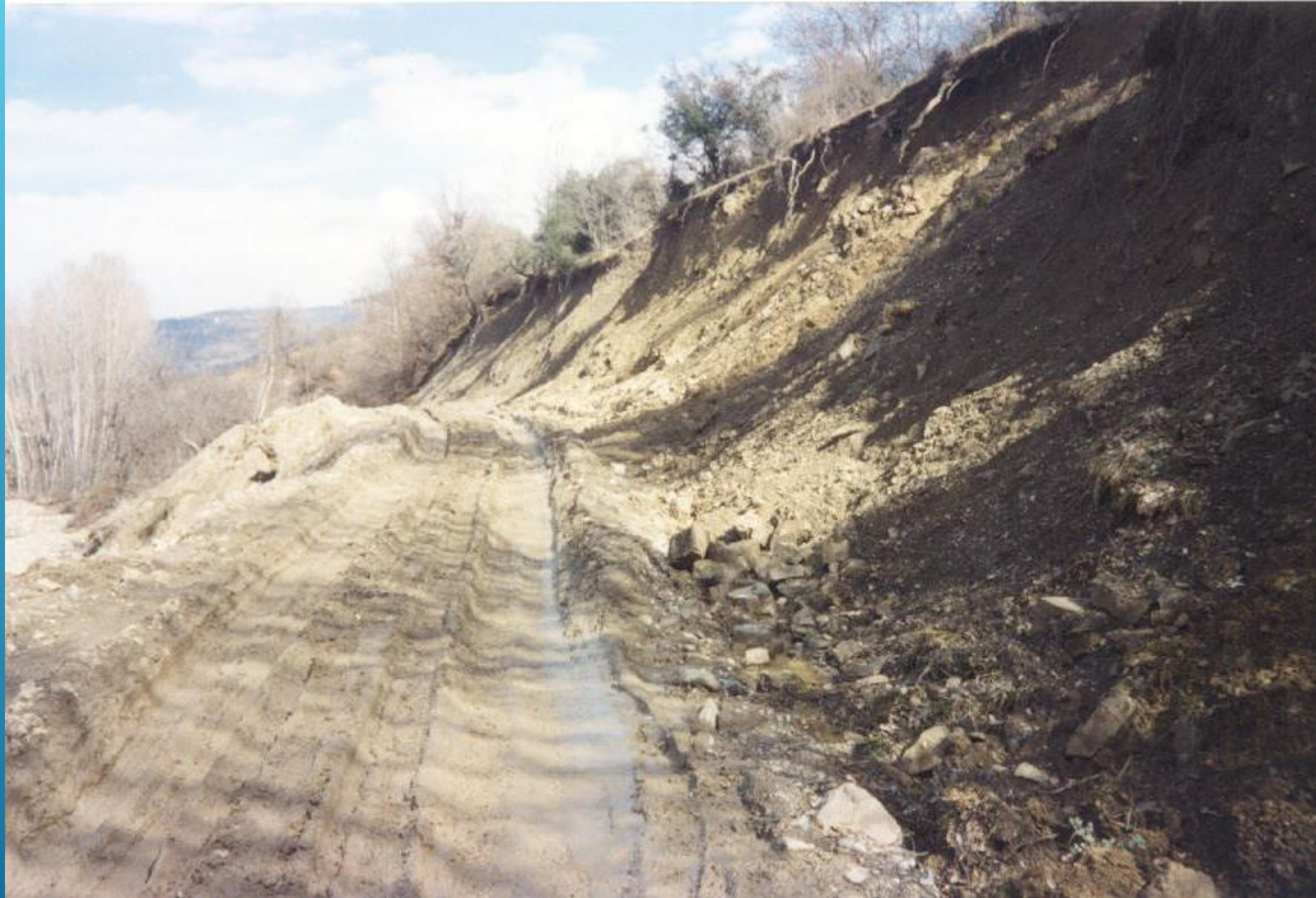
Zemini Uygun Olmayan Bir Güzergaha Yapılmış Orman Yolu
