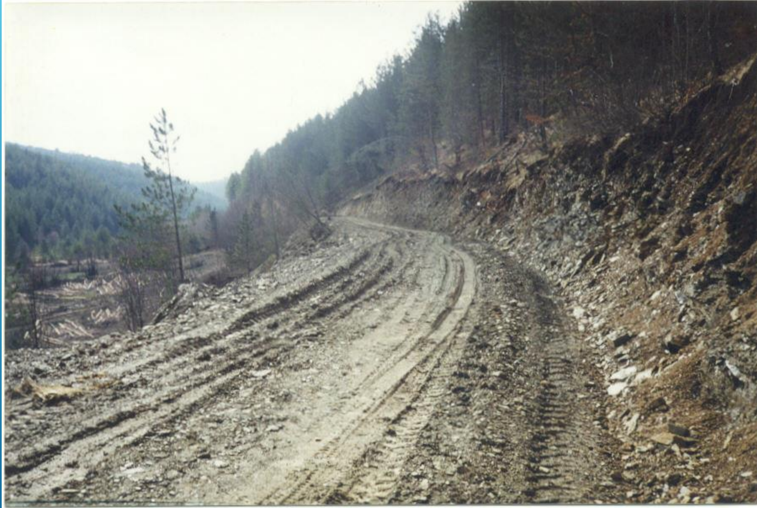
Ekskavatörle Yapılmış Düzgün Şevli Bir Orman Yolu
