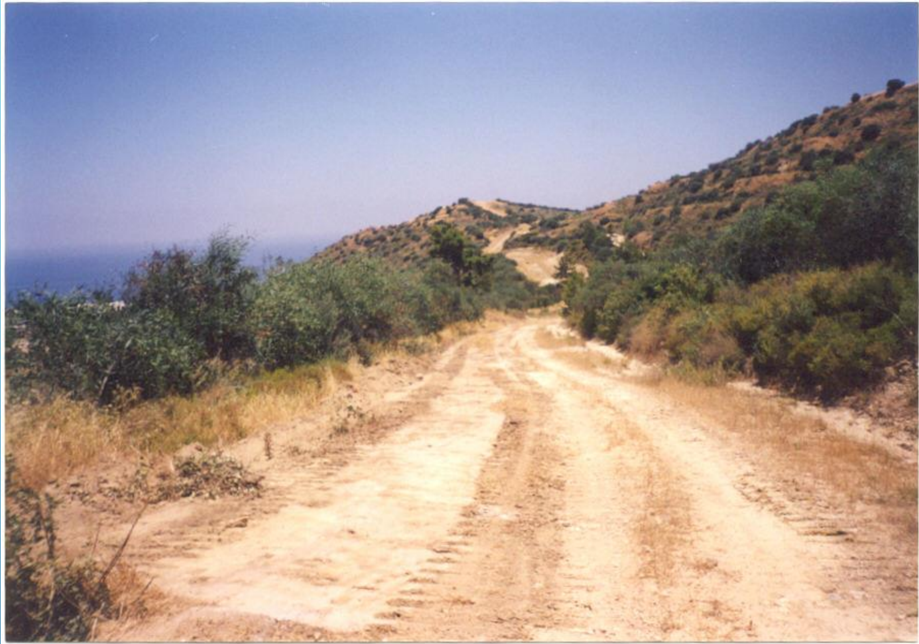
Düz Arazide İnşa Edilmiş Bir Yol
