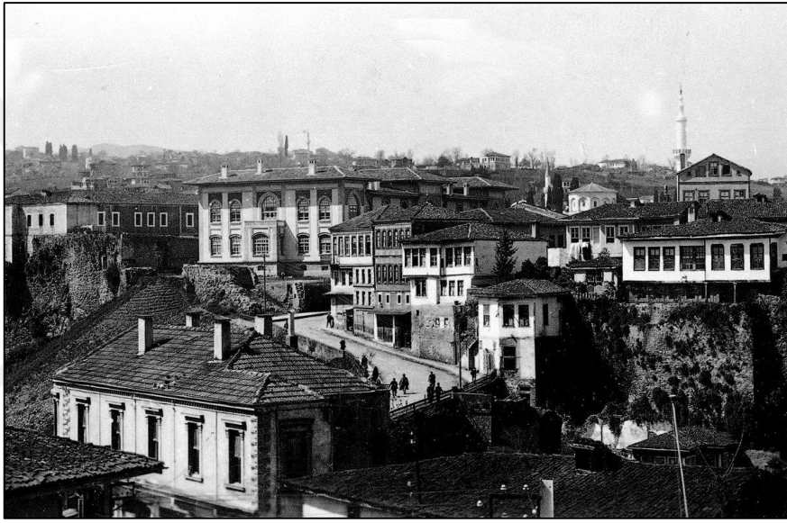
Şekil 11. Tabakhane köprüsü, 1940 (URL-3, 2017).
